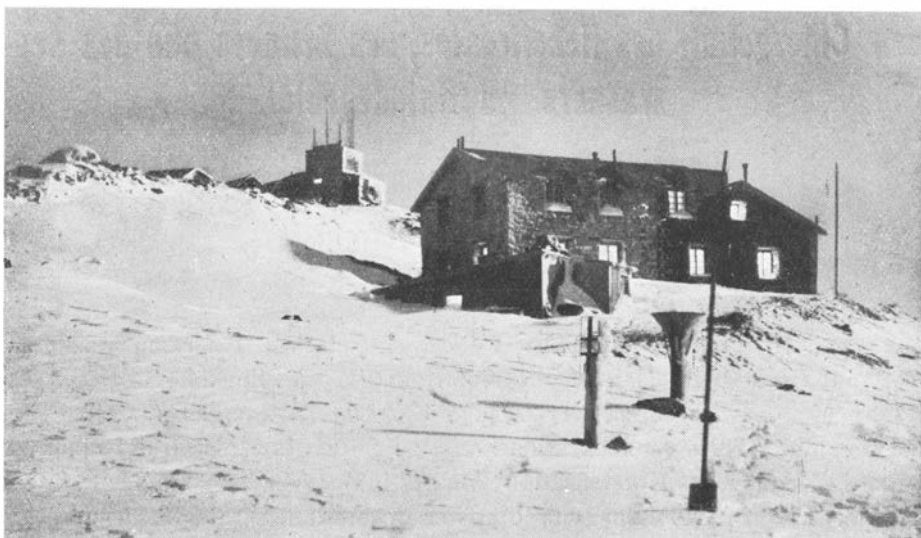
Fig. 1. Das magnetisch-meteorologische Observatorium auf dem Haldde. Auf dem Gipfel: das alte Observatorium, von Professor Chr. Birkeland im 1898, und unten das Wohnhaus, im Jahre 1911 erbaut.
